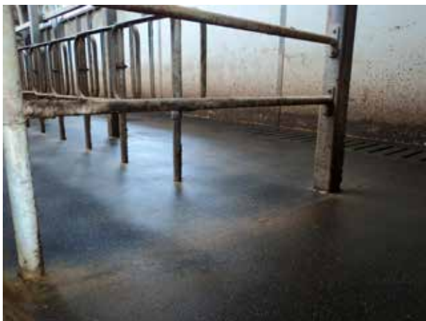
Figur 4. Gummi på gulvet i malkestalden kræver noget mere tilpasning end på gangarealet for at det ligger perfekt
