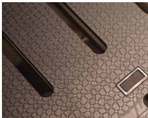
Figur 38, spaltegulvs gummimåtter som her vist er fastgjort med kiler ned i spalten
