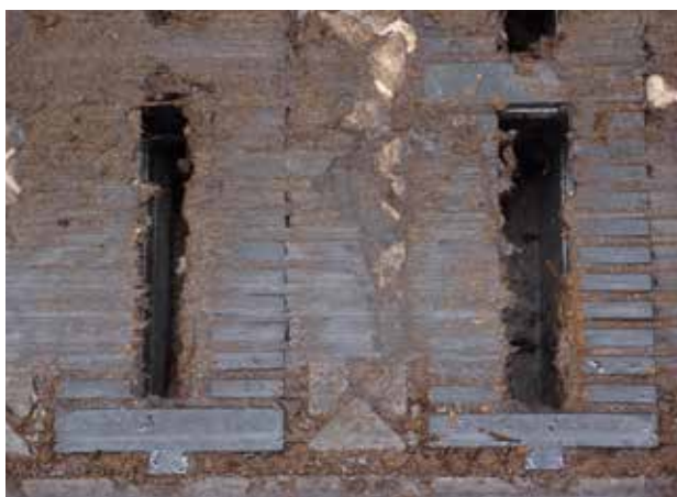
Figur 28. Eco-floor fra HZ Skibelund med gummiklapper der lukker for ammoniakfordampningen fra gyllekanalen.
