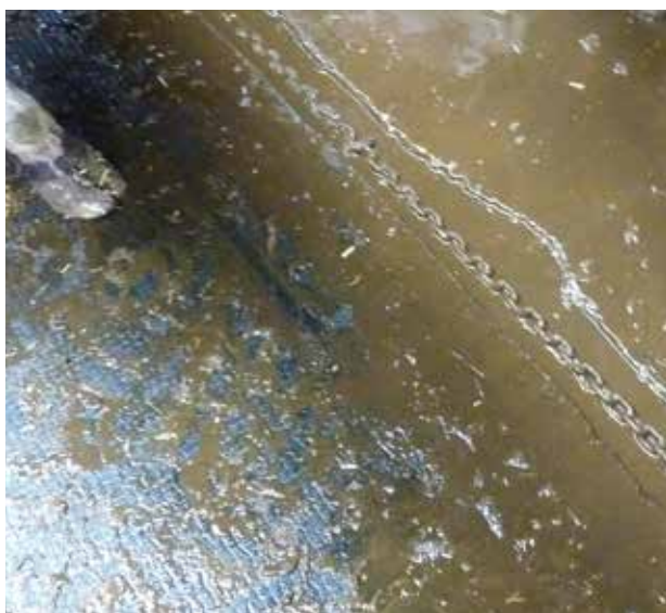
Figur 17. Kanter på gummigulvet er ødelagt af skraberens. Sæt ind i tide så skaden minimeres
