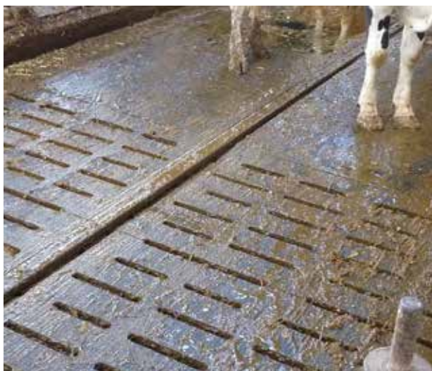
Figur 12. Jernskraber mod gummigulv har svært ved at rengøre optimalt
